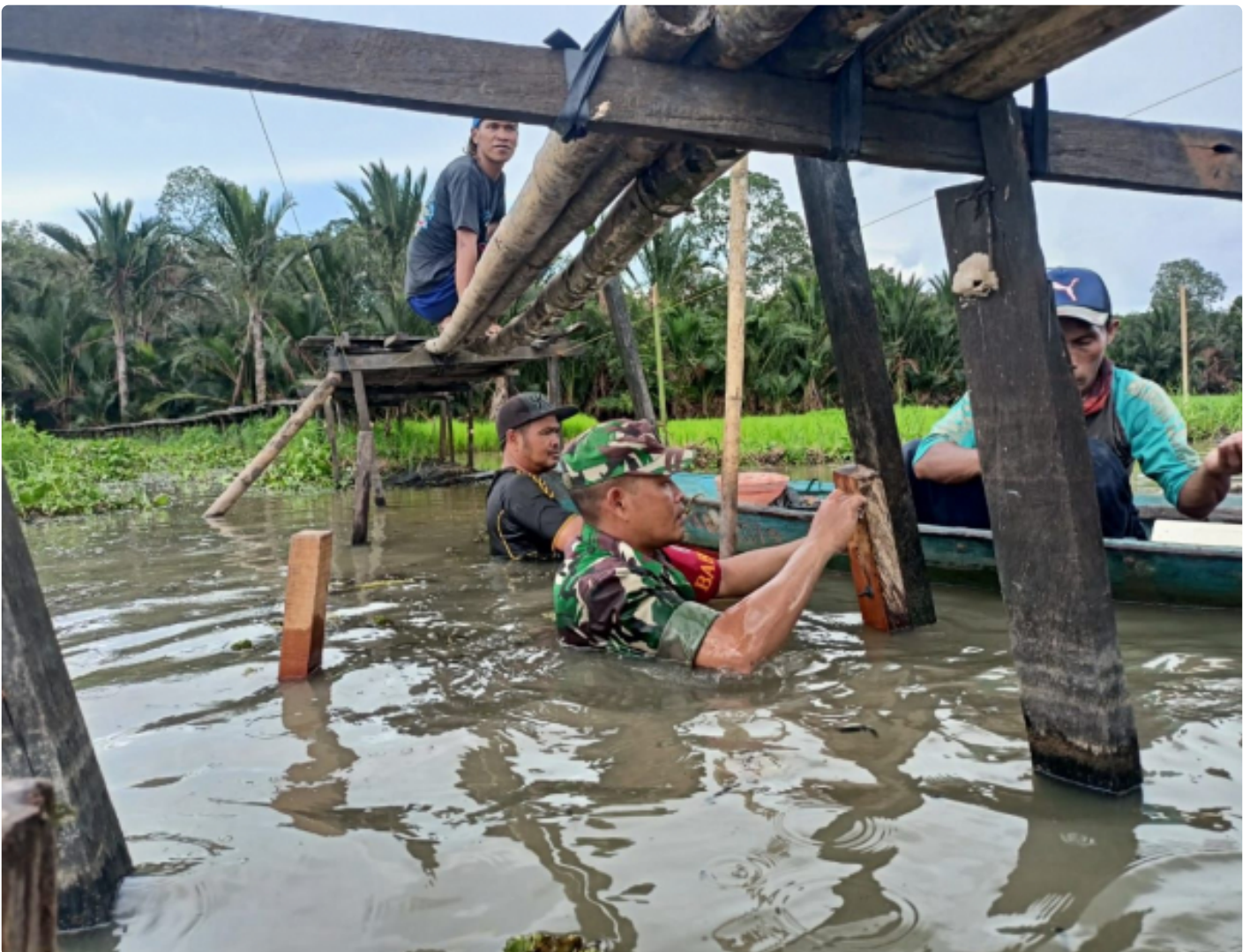
Koramil 05/Kelua bersama-sama warga gotong royong memperbaiki jembatan kayu yang rusak
