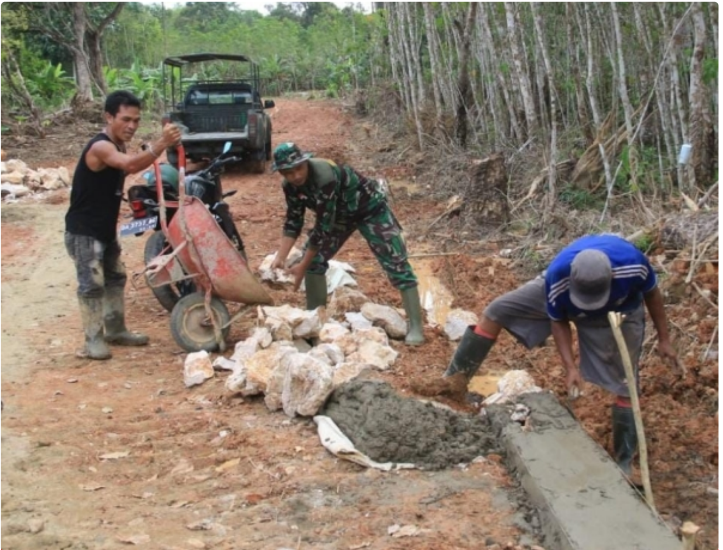
Pembuatan Badan Jalan Sepanjang 1020 meter Capai 45 Persen
