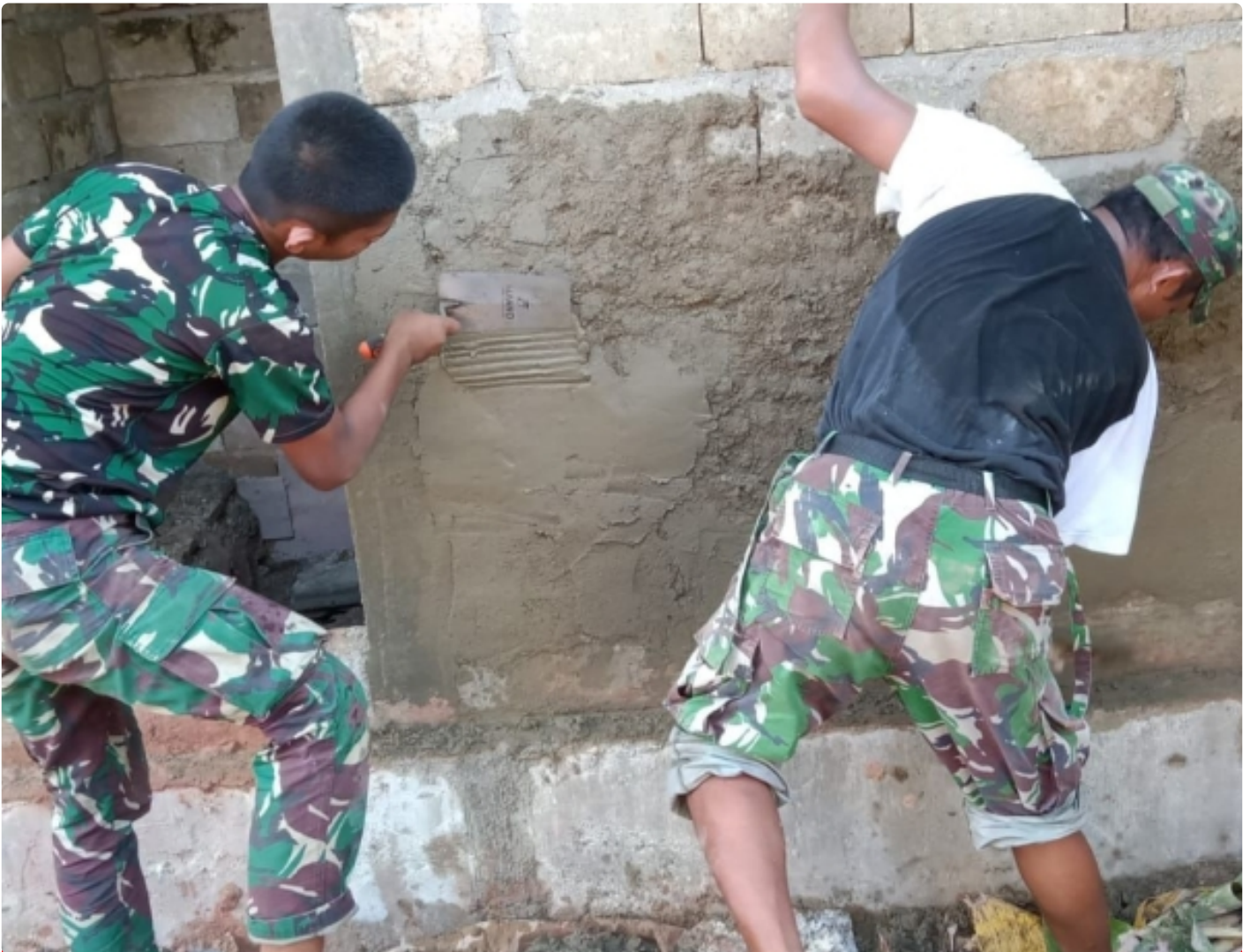
Satgas TMMMD ke-115 Kodim 1098/Tabaling Plester Dinding Mushola Nurul Iman
