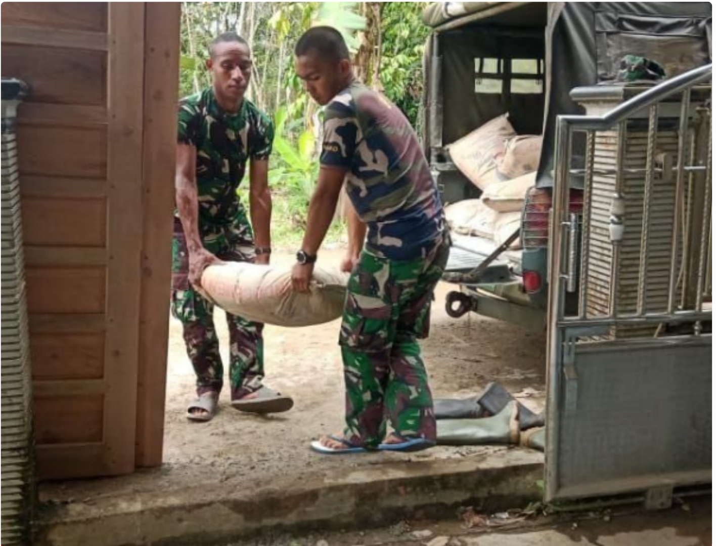
Satgas TMMD Mulai Kerjakan Rehab Kamar Mandi Mushola Nurul Iman
